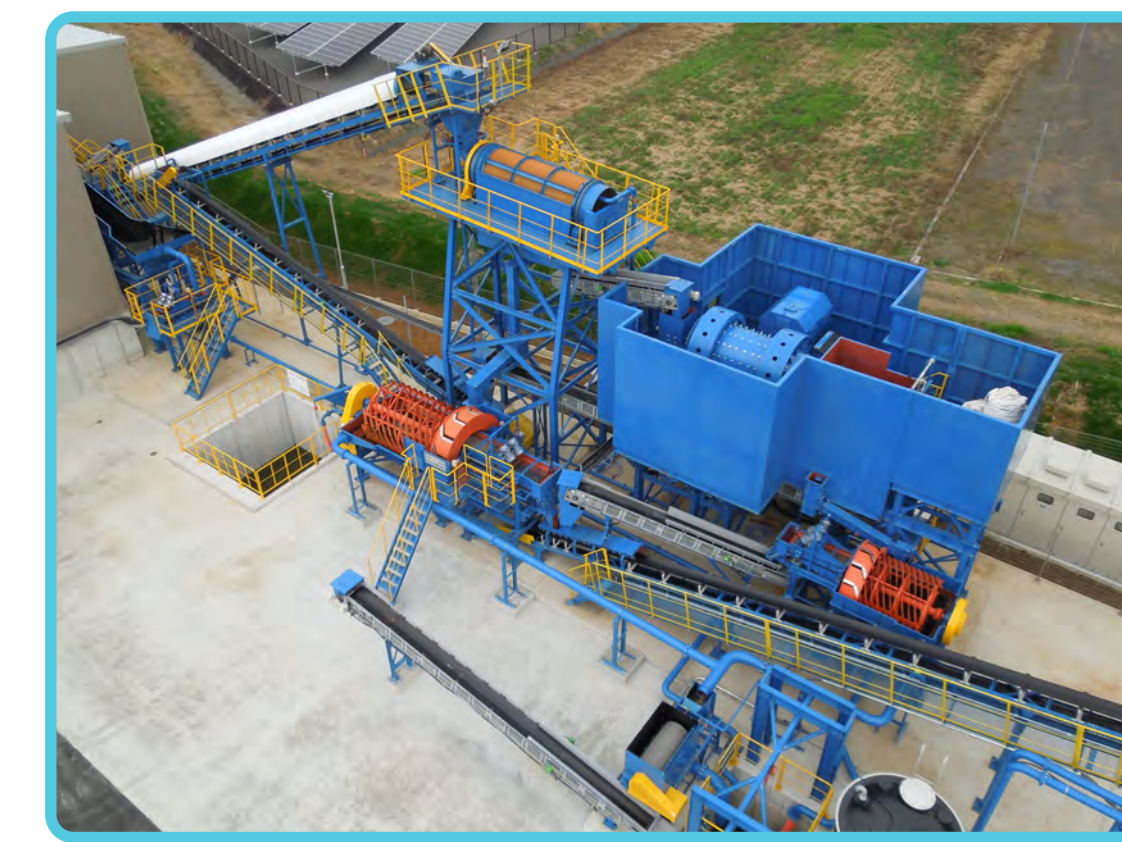
湿式破碎選別設備 全景
